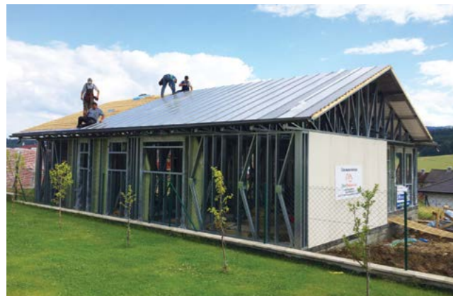
5. Konštrukcia domu pred montážou vonkajšieho opláštenia doskami Fermacell. Súčasne prebieha montáž strešnej krytiny.
