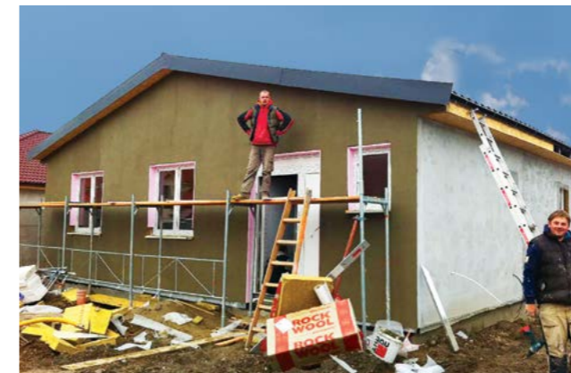
11. Realizácia kontaktného zateplenia Rockwool Frontrrock MAX 100 mm. Následne sa aplikuje penetračný náter, sklotextilná mriežka a silikónová omietka.
