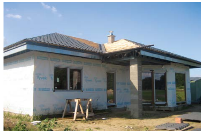
6. Montáž vonkajšieho opláštenia doskami Fermacell. V tejto fáze je stavba už vybavená oknami a dvermi.
