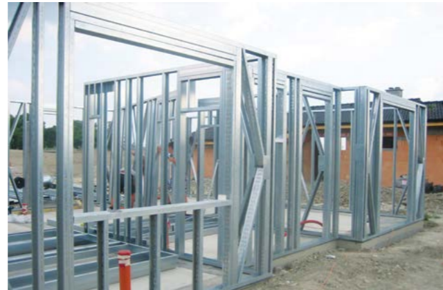
2. Montáž obvodových stien pred ukotvením. Medzi samotné profily a základovú dosku sa vkladá tesniaci pás PD 145. Základová doska je chránená proti zemnej vlhkosti.
