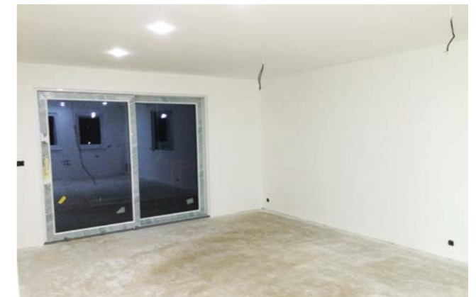
10. Nasleduje montáž interiérových sadrovláknitých dosiek Fermacell s TB hranou. Interiér je pripravený na finálne úpravy, maľovanie, podlahy, sanita...
