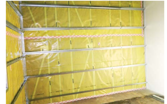
8. Pohľad na interiérovú stenu s použitím paropriepustnej fólie Dörken. Vodorovné Z profily, vytvárajú tzv. instalačnú predstenu, ktorá slúži na bezpečné umiestnenie inštalácií.
