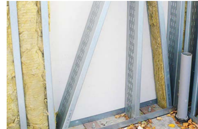
7. Vkládanie tepelnej izolácie ROCKWOOL Superrock ND 150 mm medzi profily obvodovej steny. Pohľad na obvodové štrbinové profily.
