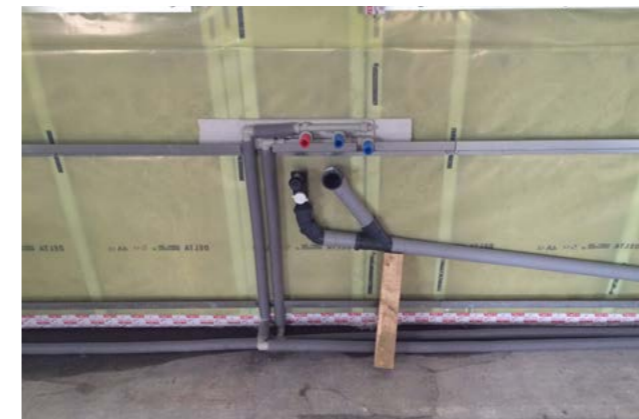
9. Inštalácia rôznych profesií spolu s výplňou z minerálnej vlny Rockwool Rockmin Plus 50 mm sú umiestnené medzi Z-profilmi, aby sa eliminoval „bodový„ tepelný most skeletu.
