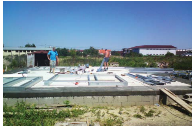
1. Po realizácii základovej dosky nasleduje príprava montáže obvodových,interiérových stien a krovu.
