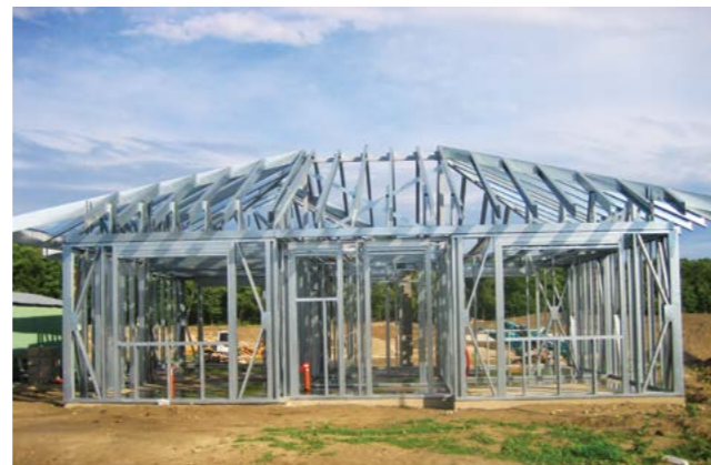
4. Pohľad na hotovú konštrukciu RD z tenkostenných profilov Lindab Construline. Konštrukcia je kotvená k základovej doske chemickými kotvami v rozstupe každých 60 cm.
