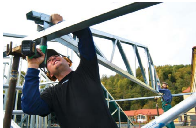
3. Montáž krovu a jeho kotvenie k obvodovým konštrukciám.
