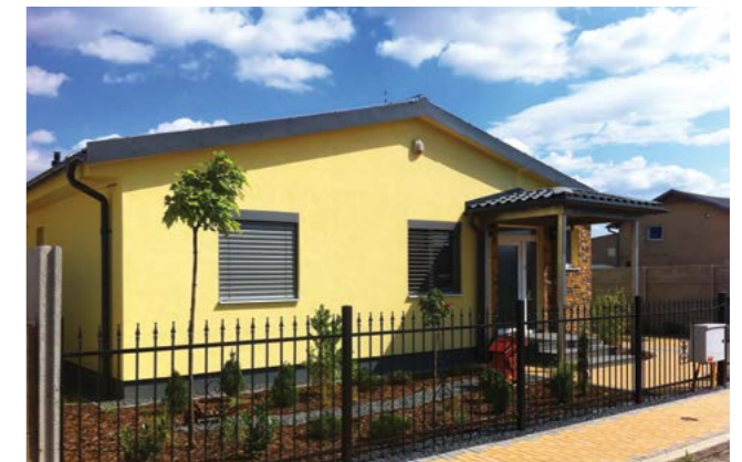
12. Pohľad z ulice na dokončený bungalov.
